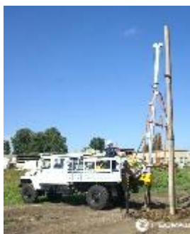
Установка опоры ЛЭП
