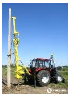
Установка опоры ЛЭП
